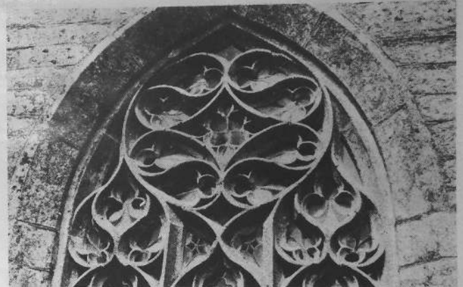
SAINT-AIGNAN - Eglise - Réseau flamboyant
