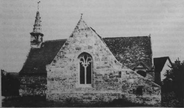
CLÉGUÉREC - Chapelle Saint-André après restauration
