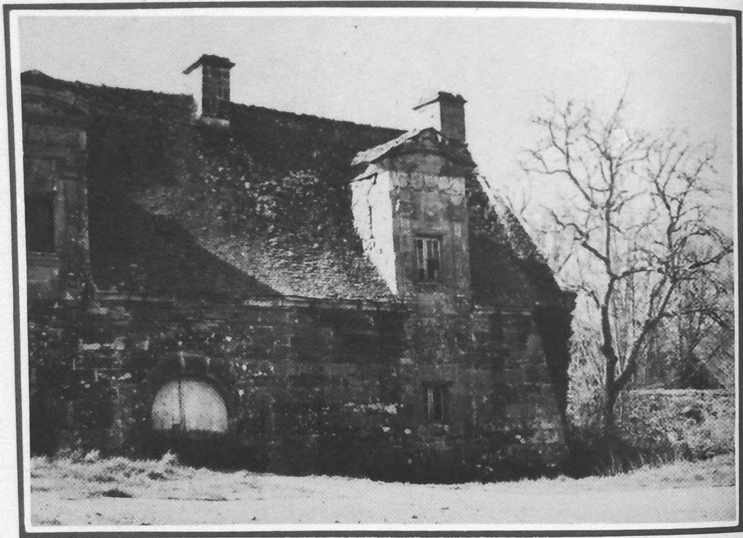
Moulin de Rimaison - Bieuzy-les-Eaux
