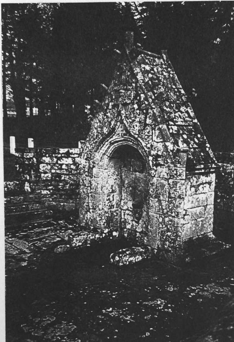
Photo 13 : Fontaine de Biengy-les-Eaux
