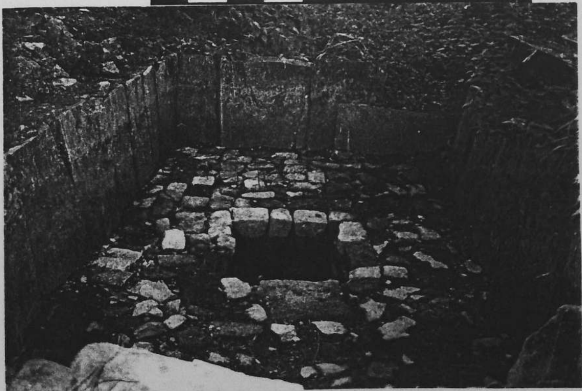
photo7 : Bassin Ouest de la cressonnière. Il est entourré de plaques de schiste et on devine le puisard, du centre.
