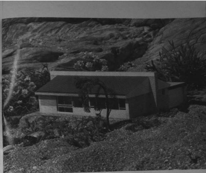
Le même procédé permet la réalisation de cette résidence de cadres
