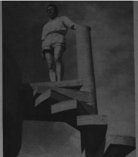
Cet escalier dessert la terrasse du logement resté de gauche
