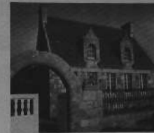
de granit et d'ardoise, que l'on croit ancienne, mais ne l'est pas, due à l'architecte J.P. Le Meur de Lannion.
