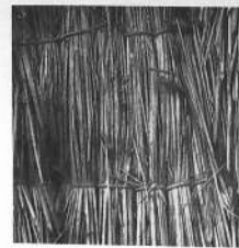
La couverture : des nattes de paille clouées l'une sur l'autre à même les planches du toit.
