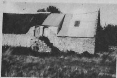
Maison de Mme de FLIGUE, à LOCMARIA- QUER Façade sud, bâtiment A, avant travaux Façade sud, bâtiment A, après travaux Façade sud, bâtiment B, avant travaux Façade sud, bâtiment B, après travaux.
