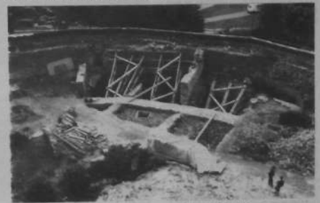
Mur des XV e -XVI e siècles appuyé contre la courtine Sud de la 3 e enceinte. (Cliché : J. Hérissey)
