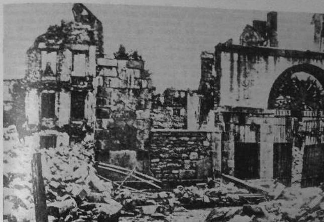
1943 - La façade du Lycée Dupuy-de-Lôme
