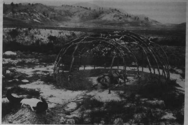
Framm ul logell-c'hweziñ : pa veze echuet ha sevel e veze gobet gant krec'hin. A-raok mont ul logell e veze padet dirak ar c'hloapenn bizon.
