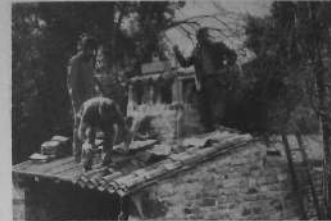
La cheminée est coiffée. Pose des tuiles à l'avant du four.
