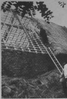
Démonstration de couverture en chaume par Serge Ferrat.
