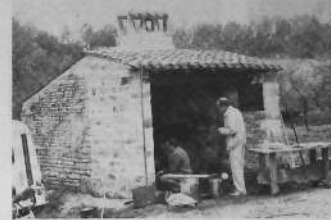
Vue du four, les travaux terminés.
