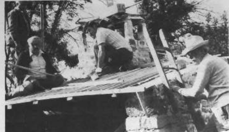
Pose des liteaux sur le devant du four.
