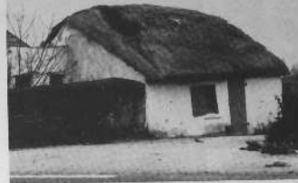
ST. JEAN DE MONTS : bourrine à une seule pièce. La bande de terre en faitière n'a pas été respectée.
