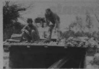
Pose des tuiles, avec rive à la saintongeaise.
