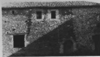
ST. MAURICE DES NOUES. Fief Mignoux : l'aile Nord, construite en petits schistes bleus disposés en lits horizontaux, porte ronde à trois clevoaux datant du XV ème . Harmonieuse disposition des ouvertures.
