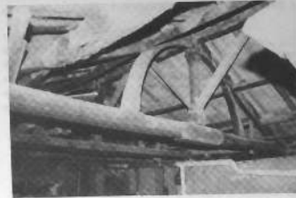
BAZOGES EN PAREDS - Le Pelliron : une ferme de la charpente en plein cintre d'époque romane. Toutes les parties sont chanfreinées, moulurées avec des double-collettes aux extrémités. La partie médiane de l'entrait est sculptée (pointes de diamant).
