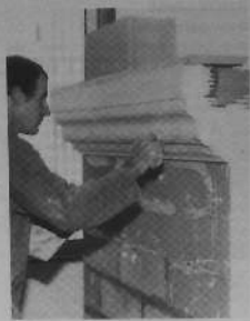
Retouche d'une corniche moulurée en plâtre après le dégras au calibré (démonstration à Venette le 22 Octobre 83).
