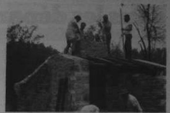
La cheminée en cours de remontage.
