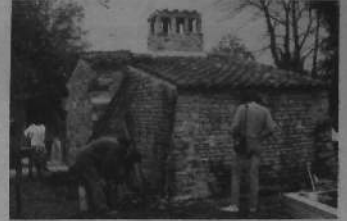
Le cul du four est recouvert de tuiles calées avec du mortier de chaux grasse.
