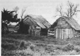
ST. JEAN DE MONTS - La Dalotrie : dépendances d'une bourrine. Construction en perches avec couverture et côté en végétal - On remarque les "barons" longues lattes maintenant les rouches en place. Les mêmes barons étaient posés sur la toiture.
