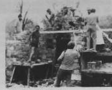
Pose de la poutre du balet.
