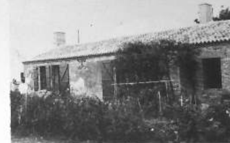
TALMONT ST. HILAIRE : maison de pêcheur en restauration. La gîte a été reconstituée avec beaucoup de soins.
