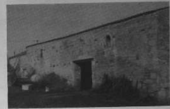
ST. ETIENNE DE BRILLOUET : La Maison Neuve. Vaste grange en parpaing de calcaire non enduit. Les chaînages d'angle et d'ouverture sont en pierres taillées. Une double rangée de "bourrisses" décape le mur.
