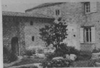
AVRILLE - Le Puy Durand. Angle Nord de la cour fermée. Construction en granit. Les ouvertures du bâtiment central ont été modifiées au XIX ème .
