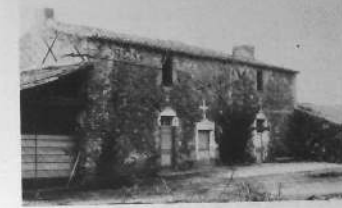
LES ESSARTS. La Basse Gontrie : maison-type du Bas-Bocage. Appareillage en schiste. Cheminée sur pignon, corniche en bois.
