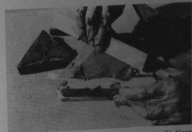
c. Fabrication d'un carrelage : cadre en bois rempli d'argile.
