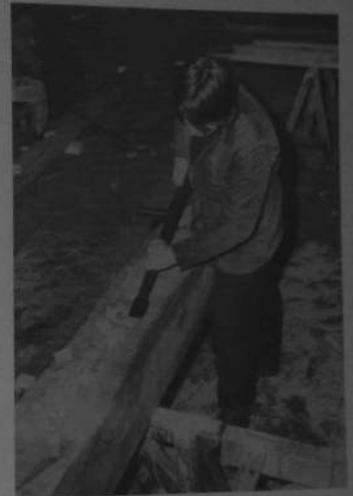
b. Charpentier taillant les mortaises avec le biseigle
