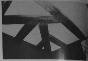
b. Vannes. Poutraison de type primitif, avec "coyer" diagonal sur l'angle.
