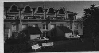
La résidence Alfred de Musset à Fougères, une réalisation consulaire.
