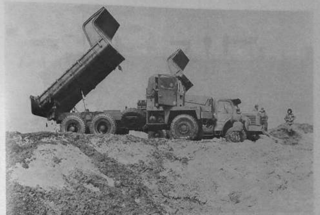
Bennage du mazout dans une fosse creusée dans la dune
