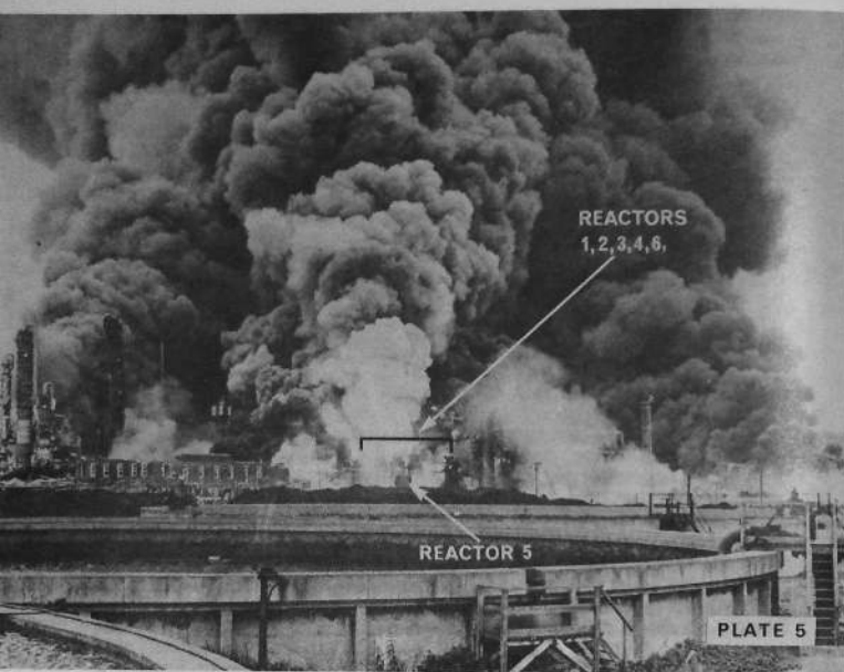
Une vue de la catastrophe de Flixborough : les incendies vus du Sud-Ouest.
