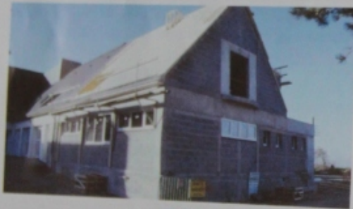
Fin des travaux en avril 2002 au foyer
