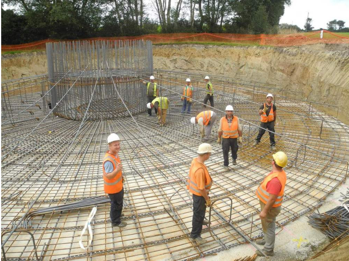
Figure 7 - La face enterrée de l'éolienne 8
