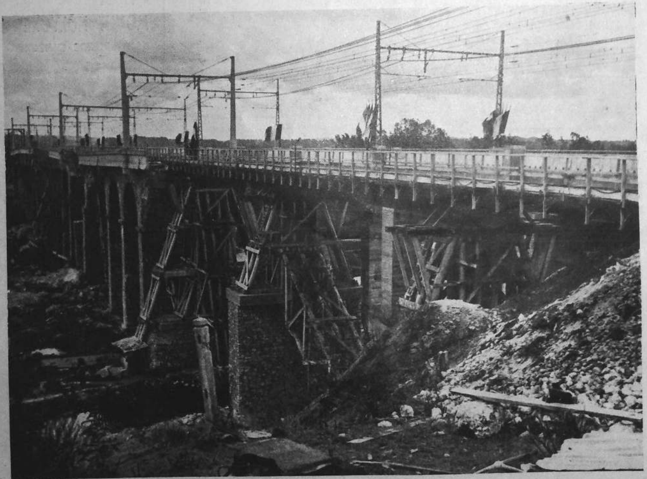
Le pont provisoire construit en deux mois.
