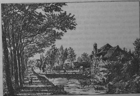
RENNES. — Le Mail. (Commun. de M. Guillet.) Un des anciens canaux latéraux du Mail. Dessiné par J. Thouault.
