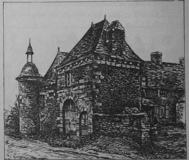
PLEINE-FOUGÈRES. — Ancien Château de Chauffaux.
