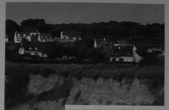
Falaise en érosion à Tégou, sur Mer (2018). © Nicolas Buisson, UBO
