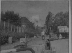
Durant les prochains mois de travaux, les usagers sont invités à la prudence et à respecter le plan de circulation adapté au centre bourg.
