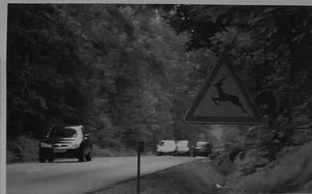
Chantier Une nouvelle route à 2 x 2 voies sera construite en lieu et place de la route actuelle dans la forêt d'Araize.
