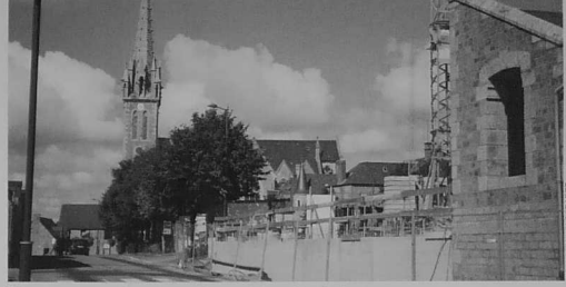
TRAVOUX Le nouveau bâtiment devrait être terminé en avril prochain.
