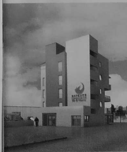
Un centre d'entraînement pour les sapeurs-pompiers est en construction à L'Hermitage.
