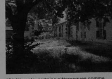
19 bâtiments, certains pittoresques comme le hameau des écuries, seront conservés pour être réutilisés.
