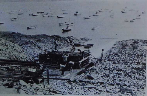
Les travaux pour l'aménagement du port de plaisance
