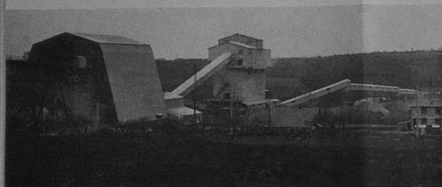
AU PREMIER PLAN LE CONCASSAGE, PUIS LE CRIBLAGE ET STOCKAGE.
