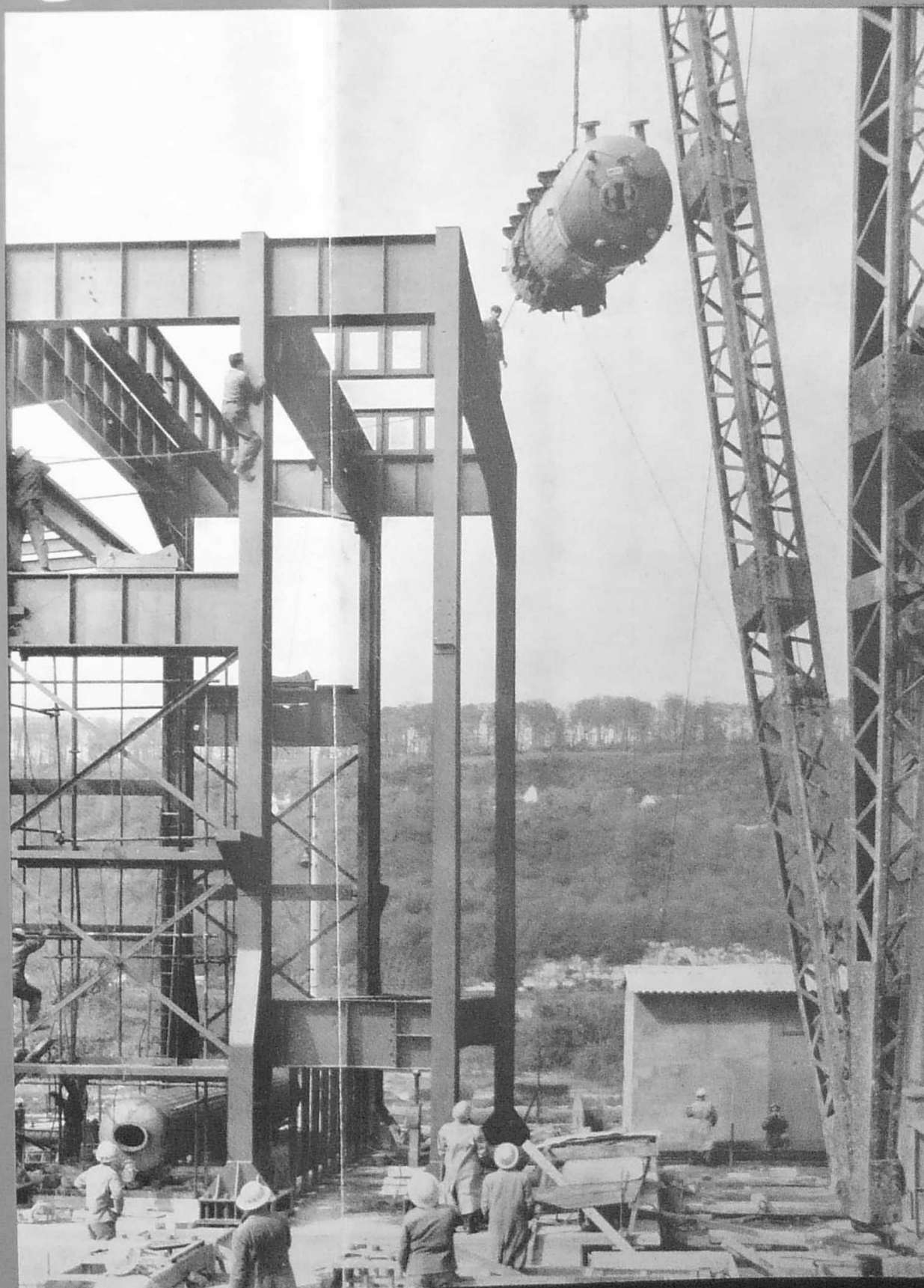
CHAUDIÈRE TYPE VU en montage à la RAFFINERIE DE NORMANDIE Cie Fse de Raffinage Document STEIN & ROUBAIX
