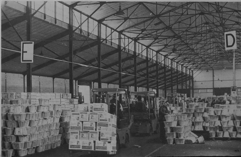
Aspect d'une partie du hangar à primeurs du quai Wilson
