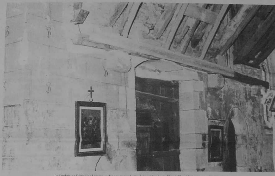
Les lambris de l'église de Loguivy à disparu par endroits, laissant le chœur libre à l'humidité qui poursuit ses ravages.
