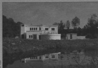
Usine de pompage à Yvias sur le Leff.
