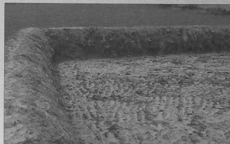
Le même talus en 1995 après les inondations : le talus est intact et a joué son rôle hydrologique.
